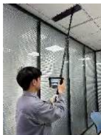
проверка потолочных воздуховодов
